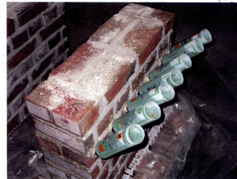
Bild B1: Durchführung der Mauerwerksinjektion mittels druckloser Injektion
